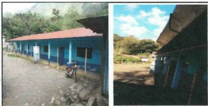
Foto 5: se necesita remozar el cerco de la escuela, colocacion de tubos para envejada de agua pluvial, y pintar todos los ambientes de la escuela
